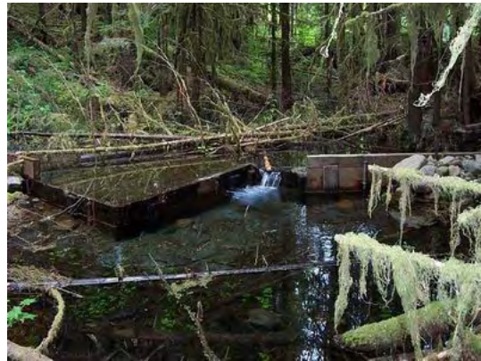
(d) Plank Zig-zag weir. Lear Springs.
